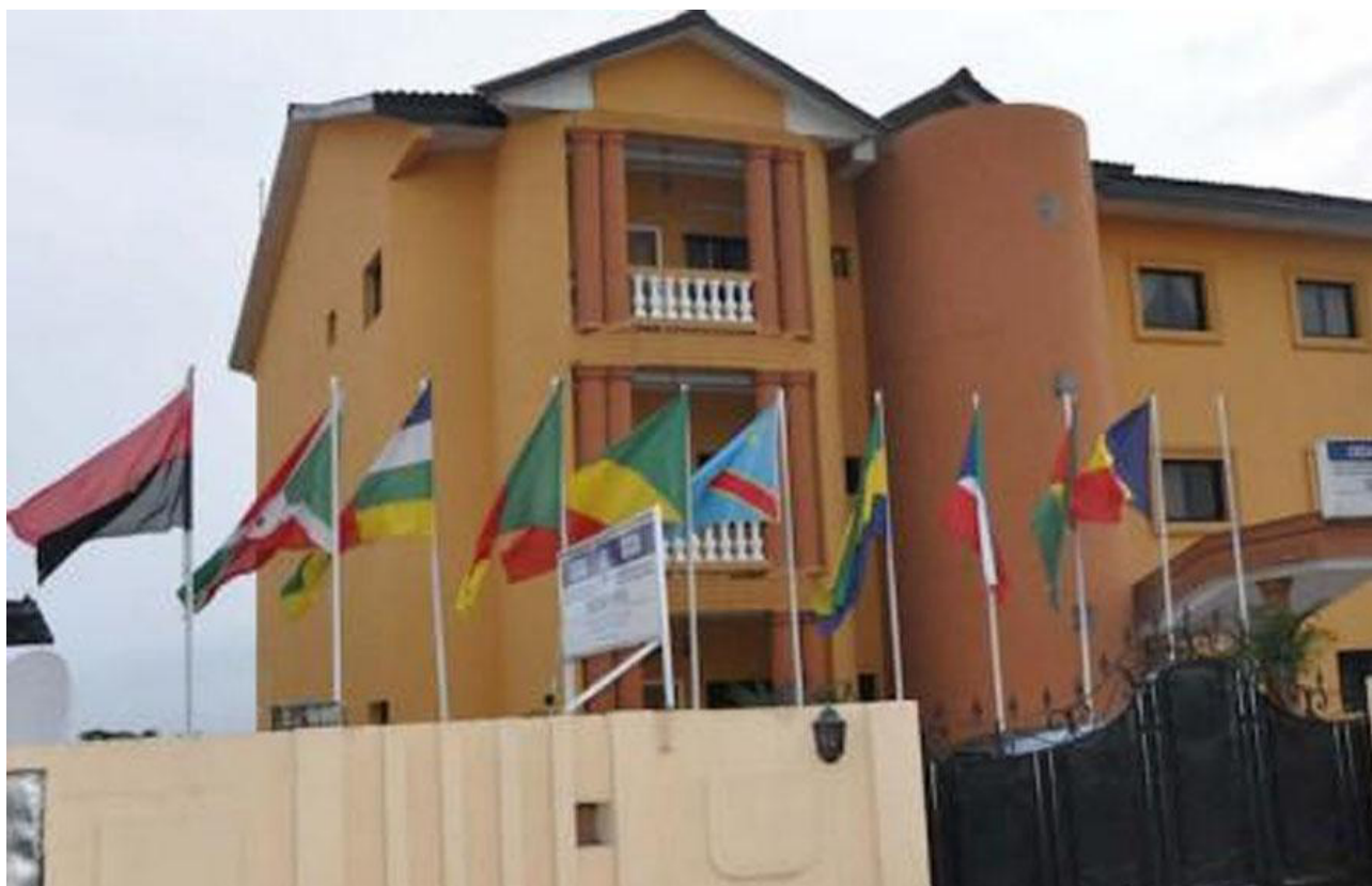
Le siège de la CEEAC à Libreville, au Gabon
